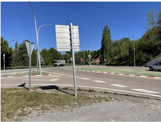
L'accés nord-oest de Ripoll on es farà la nova rotonda | Ajuntament de Ripoll
