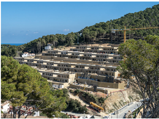
Obres a la urbanització de Sa Riera, Begur MIQUEL RIERA.
