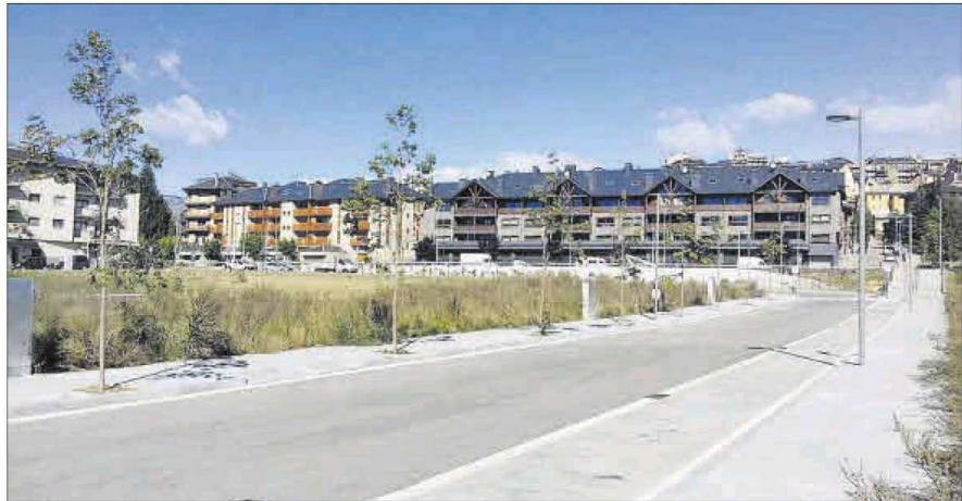
El sector de la Pedragosa on s'han de construir els pisos de protecció oficial
