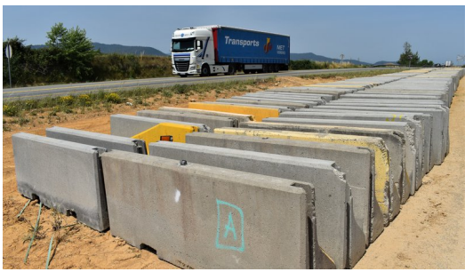
Les tanques de formigó, preparades per ser col·locades a la mitjana R.E.
