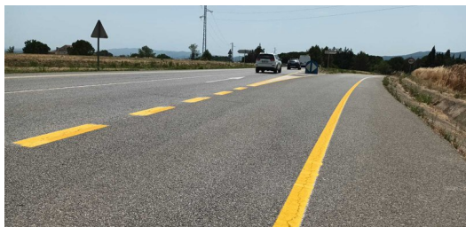
Les línies grogues d'obres que estan pintant a la carretera. AJUNTAMENT DE BANYOLES.
