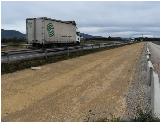
La carretera, tal com va quedar en aturar-se les obres. R. E.
