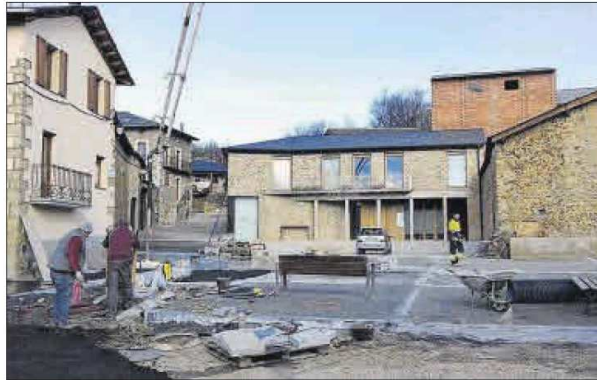
La construcció de la plaça davant el nou ajuntament
