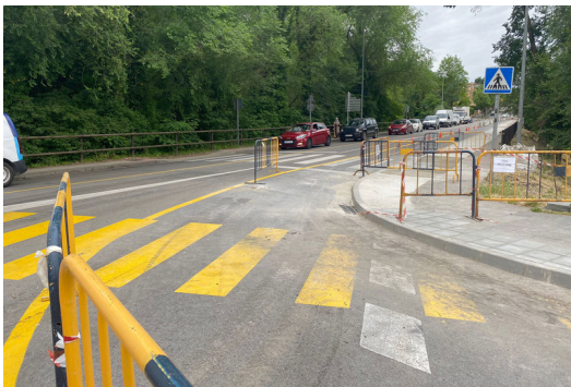
Senyalització de l'indret on es faran les obres AJUNTAMENT D'LOT.
