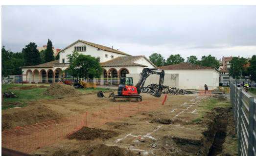
Una excavadora a la seu de l'Idibgi al Parc Hospitalari Martí i Julià IDIBGI.
