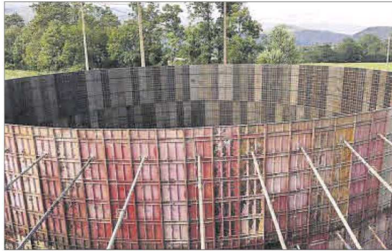
Les obres del dipòsit municipal de Bellver de Cerdanya
