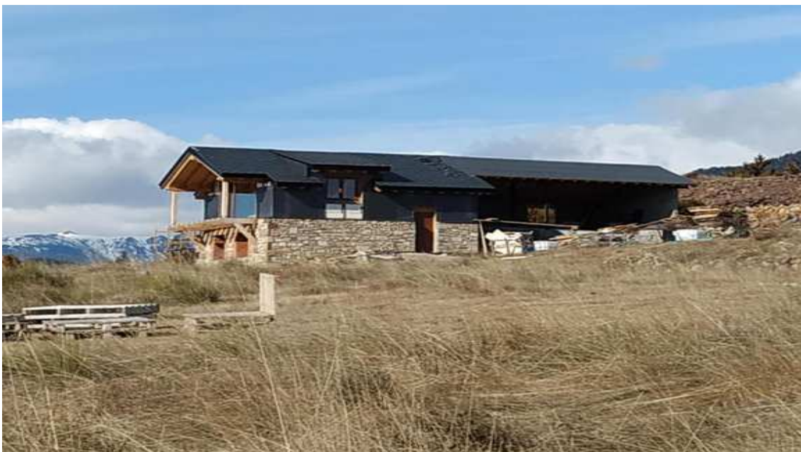
Imatge de l'edificació objecte de polèmica a Bellver de Cerdanya / ACN
