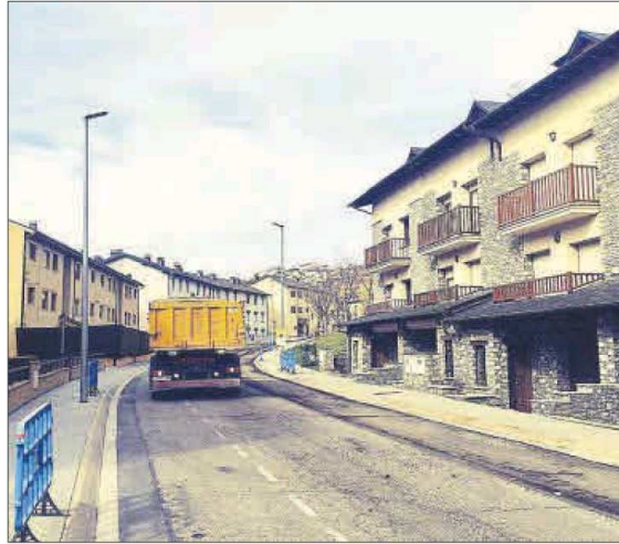
El carrer Pompeu Fabra millorarà el seu paviment AJUNTAMENT DE PUIGCERDÀ
