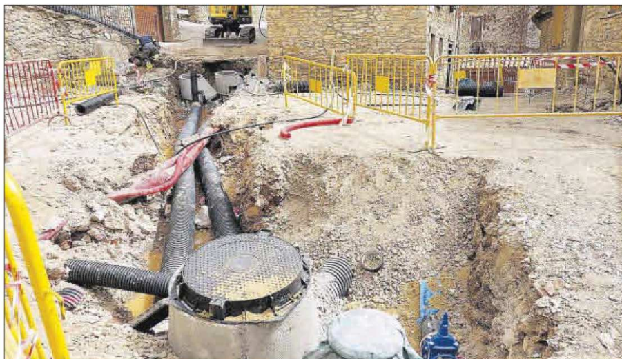
Les obres a la plaça Major ja mostren els dos tubs d'aigües pluvials i residuals per separat AJUNTAMENT DE PRULLANS
