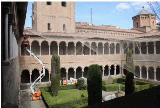
El procés d'instal·lació de la xarxa, mitjançant una grua ACN.
