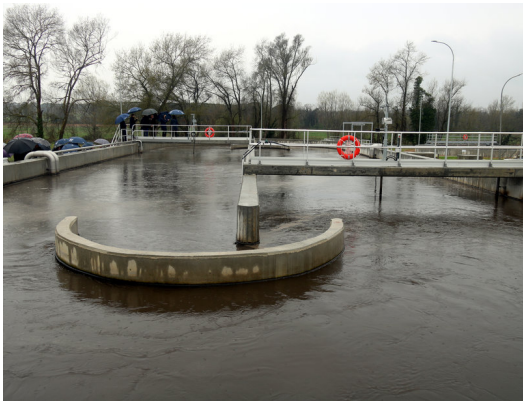
La planta depuradora de Cassà X. PI / ACN.
