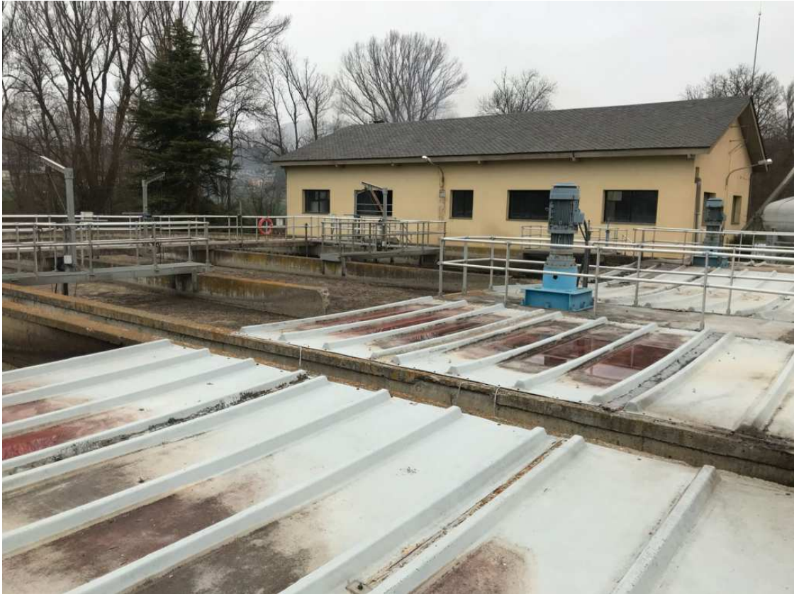
La depuradora de Puigcerdà. / M.F.C.
