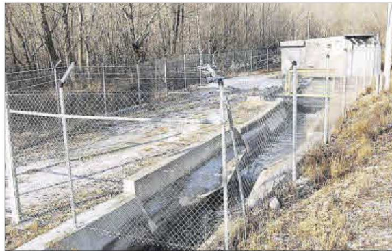
La captació de Ruités que aporta aigua a Puigcerdà
