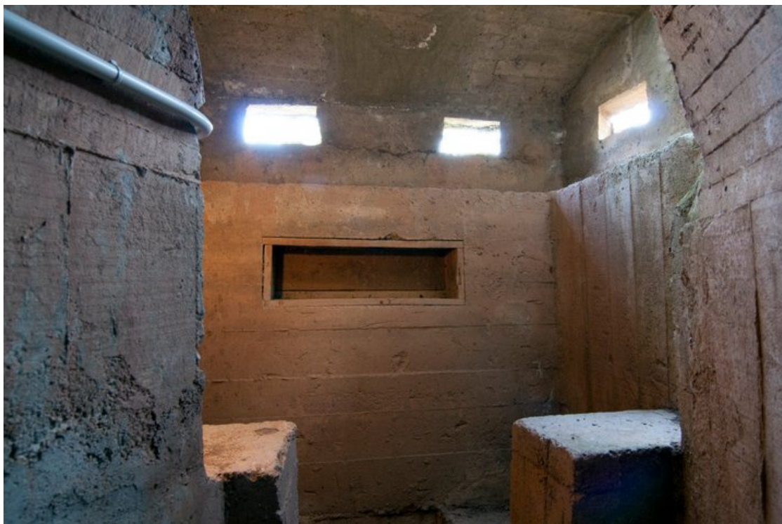
Interior d'un búnquer. / PARC DELS BÚNQUERS
