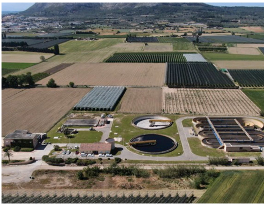
L'EDAR de Torroella, en una vista aèria CACB.
