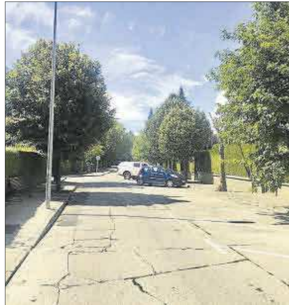
El Camí de Llivia abans de les obres
