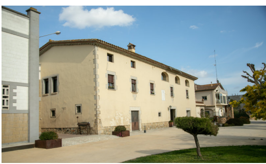
Can Bellsolà forma part del catàleg de masies de Girona i està inclòs en l'àmbit on s'ha de fer el futur hospital Trueta QUIM PUIG.
