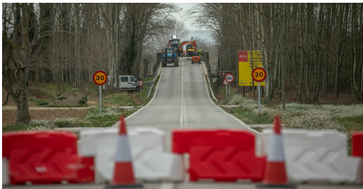
Els operaris, al fons de la imatge, treballant amb la via tancada al trànsit, ahir al matí QUIM PUIG.
