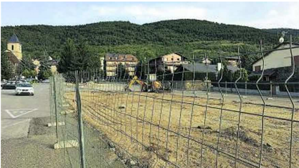
Les obres de renovació urbanística al centre d'Alp | ARXIU/M,S.
