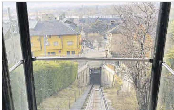
L'ascensor inclinat que se substituirà aquest any
