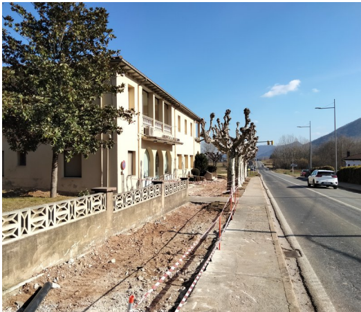
Renovació de serveis a l'Hostalnou J.C.
