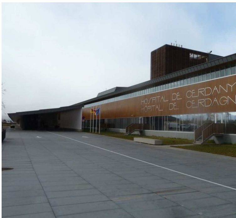
La façana principal de l'hospital transfronterer i l'accés a u J.C.
