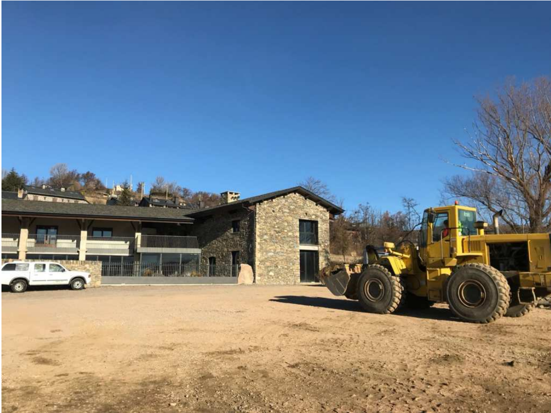
Les obres de la futura plaça Major de Bolvir. / M.F.C.
