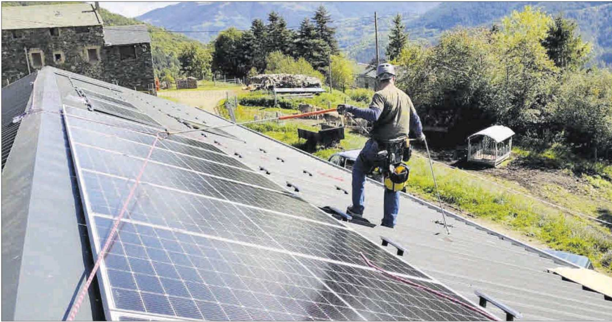
Un tècnic de la Cooperativa Cerdanya Solar instal·lant plaques fotovoltaïques en una teulada
