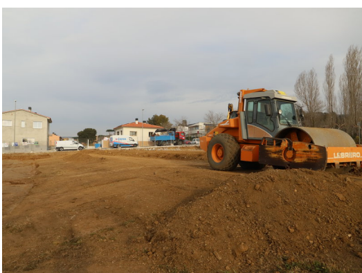
Treballs al solar de la futura biblioteca cristinenca, al nou sector de la Teulera E.A.
