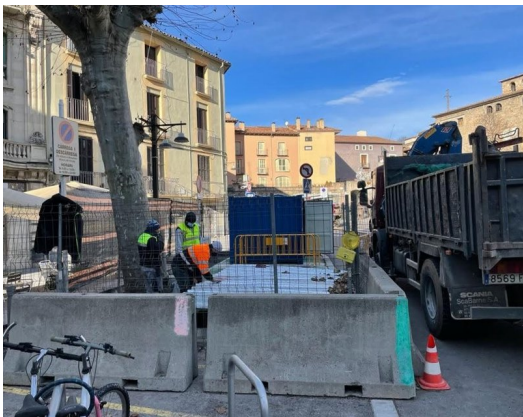
Les obres a la plaça de l'Ajuntament, que duraran uns dos mesos i mig AJUNTAMENT DE RIPOLL.
