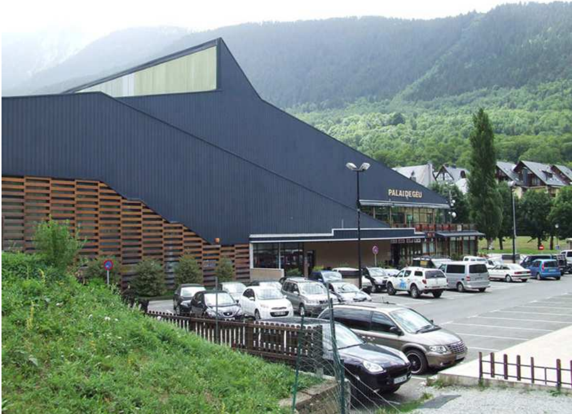
A Vielha hi ha un dels equipaments esportius més importants del Pirineu, el Palai de Gèu
