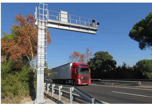
El radar de tram, al costat del poligon de Mango. | Servei Català de Trànsit
