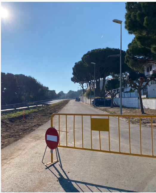
Les obres de la futura via verda, a la sortida del municipi, en direcció a Platja d'Aro J. TRILLAS.
