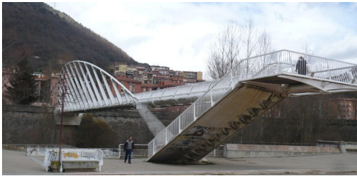
Una vista general del pont de Calatrava amb les escales d'accés en primer terme J.C..
