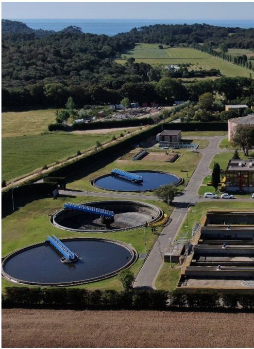
Panoràmica aèria de l'estació depuradora d'aigües residuals de Palamós CONSORCI DE LA COSTA BRAVA.
