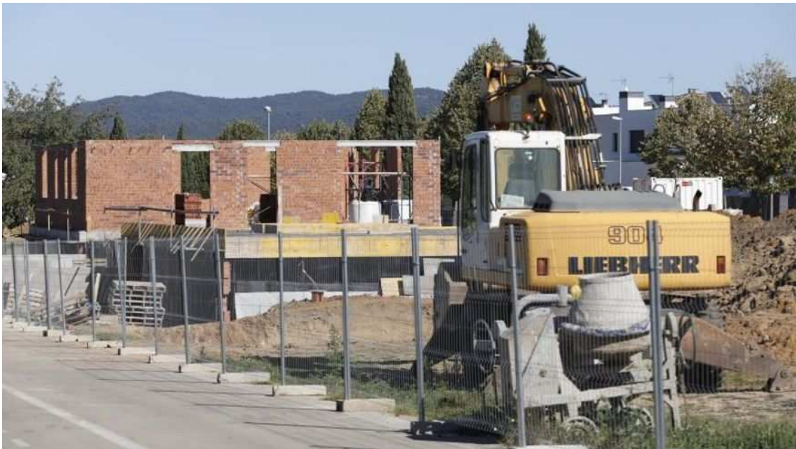
Una casa en construcció a finals d'octubre a Fornells Aniol Resclosa
