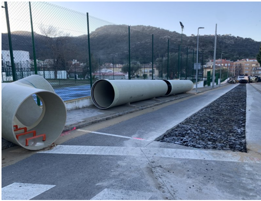
Primers treballs per millorar el drenatge AJ. ROSES.
