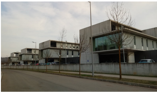
Una vista exterior de les quatre unitats d'hospitalització del centre garrotxí J.C.
