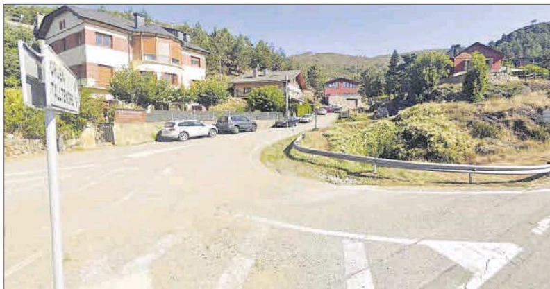
El tram final del torrent de Codolet en la intersecció amb la carretera N-260 a Bellver
