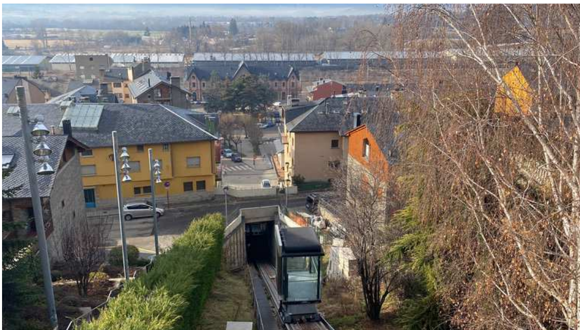
L'ascensor inclinat de Puigcerdà al mig del seu recorregut / Albert Lijarcio
