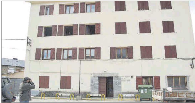
L'antiga caserna de la Guàrdia Civil de Llívia, que albergarà el nou Ajuntament
