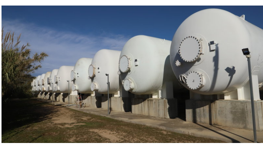
Tancs d'aigua a la dessalinitzadora de Blanes E.A.
