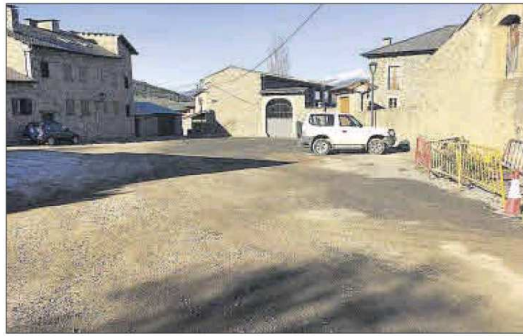
Les obres al centre de Bor per fer-hi la plaça Major
