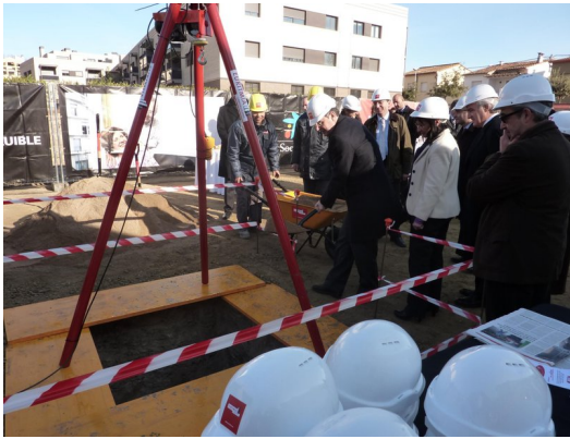
Col·locació de la primera pedra d'un bloc de pisos de lloguer, a Banyoles. R.E..
