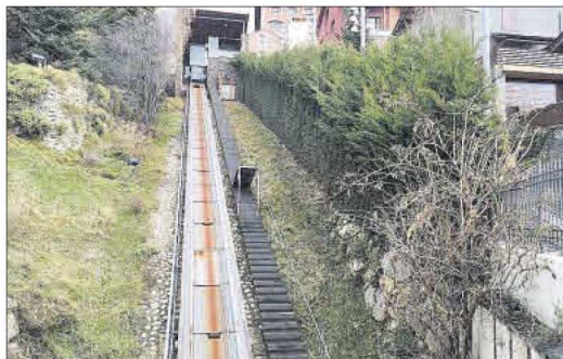
L'ascensor inclinat de Puigcerdà que porta al centre
