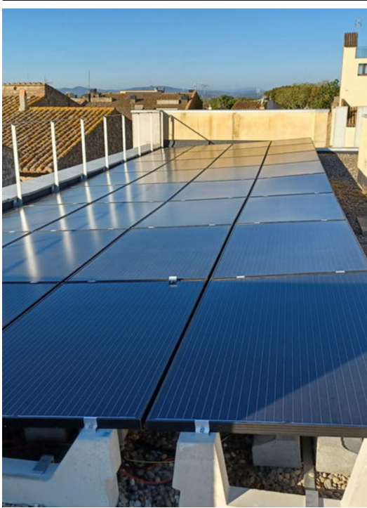
Els panells d'energia solar fotovoltaica que s'han posat per a l'autoconsum de Can Mach AJ. TORROELLA DE MONTGRÍ.
