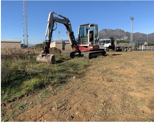
Treballs de condicionament del terreny on s'està preparant el circuit de BTT de Roses AJ. DE ROSES.
