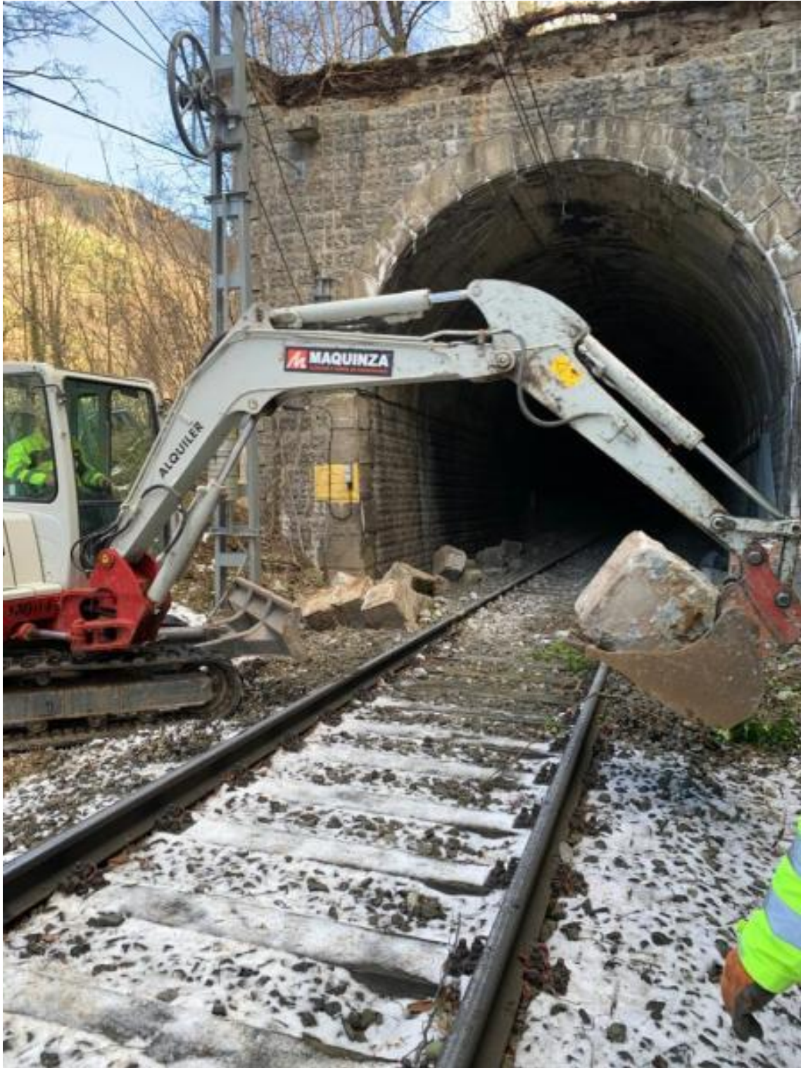
Operarios retiran las rocas desprendidas en la boca del túnel
