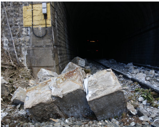
Les roques, de grans dimensions, que es van desprendre del talús superior al túnel sobre la via L. CASADEMONT / ACN.
