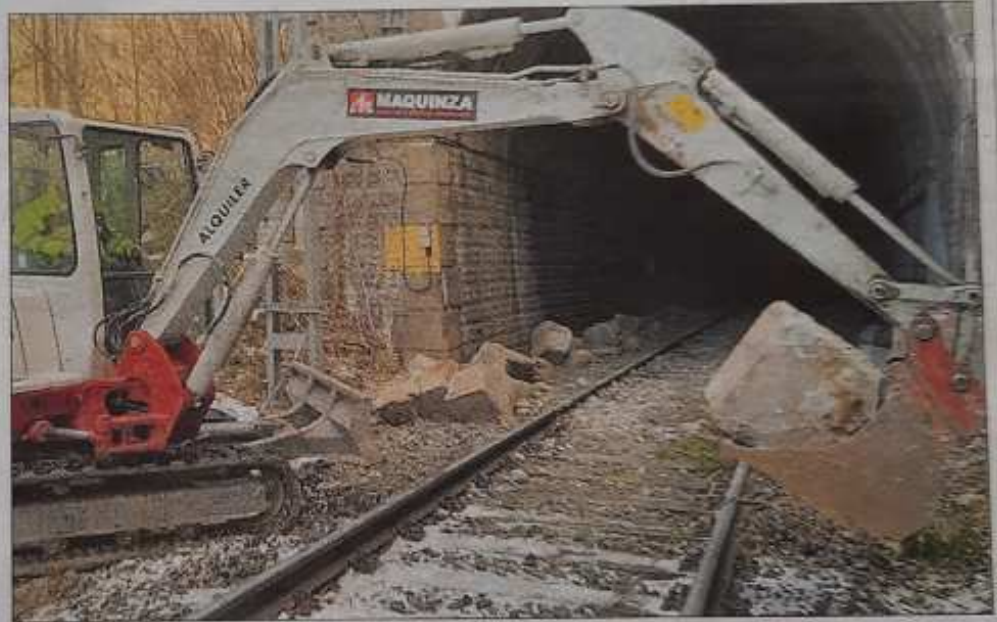
Una excavadora retira les roques esllavissades
